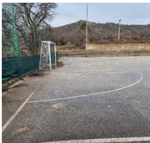
Igralište (prije rekonstrukcije)
