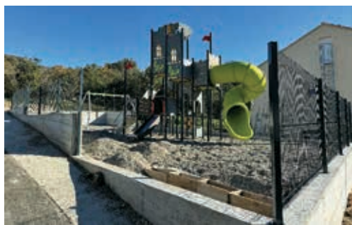
Dječje igralište Lovreć (u fazi izgradnje)
