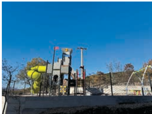
Dječje igralište Lovreć (u fazi izgradnje)
