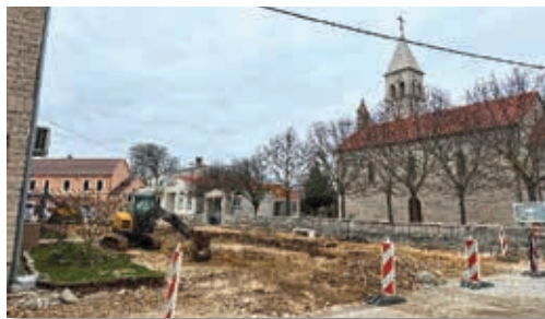
Radovi na Franjevačkom trgu, studeni 2024.
