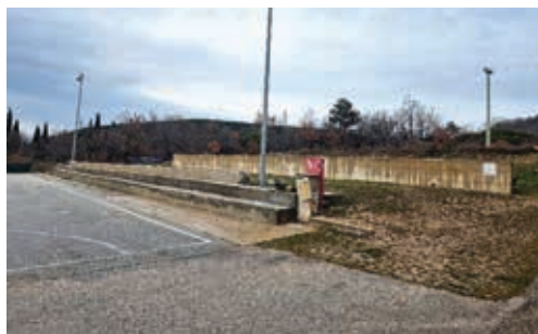
Igralište (prije rekonstrukcije)
