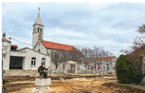
Radovi na Franjevačkom trgu, studeni 2024.
