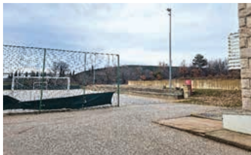
Igralište (prije rekonstrukcije)
