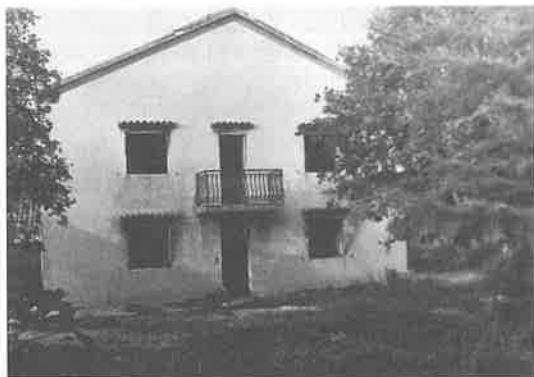
Zapaljena župna kuća
