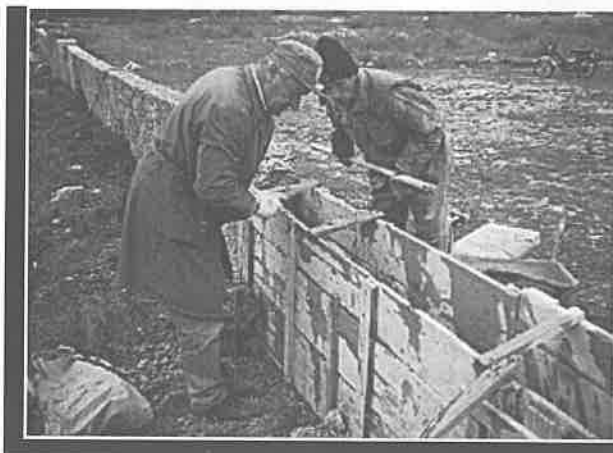
Obnova groblja u Drinovcima
