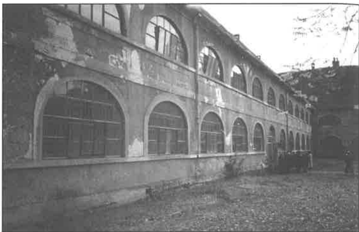
Kaznionica u Staroj Gradišći
